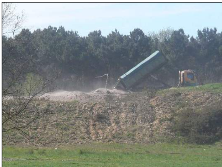
Déchargement des DND sur la plateforme
